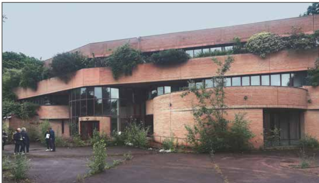
Façade nord, en 2021
