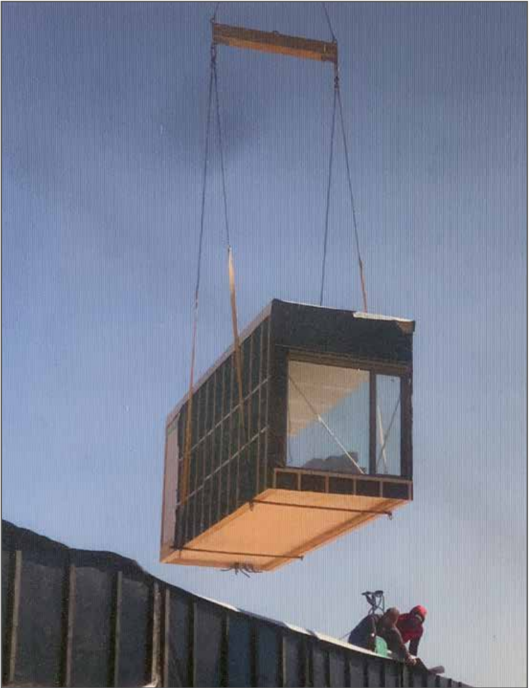
LEVAGE D'UN MODULE
