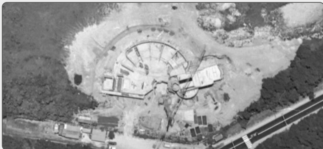
Terrassement d'une fraction de la butte du Fort de Rosny, 1985
